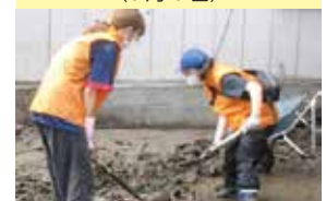
久慈市街地での泥上げ作業 (9月3日)
